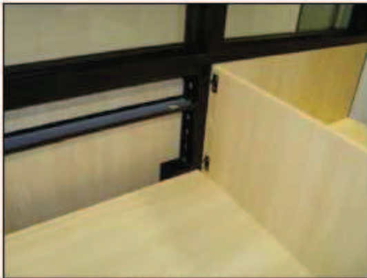
FIXAÇÃO DOS PAINÉIS
